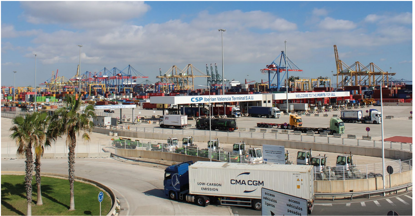
Terminal de CSP Spain en el Muelle Príncipe Felipe del Puerto de Valencia. Foto J.C.P. CSP Spain terminal at Muelle Príncipe Felipe in the Port of Valencia. Photo J.C.P.
