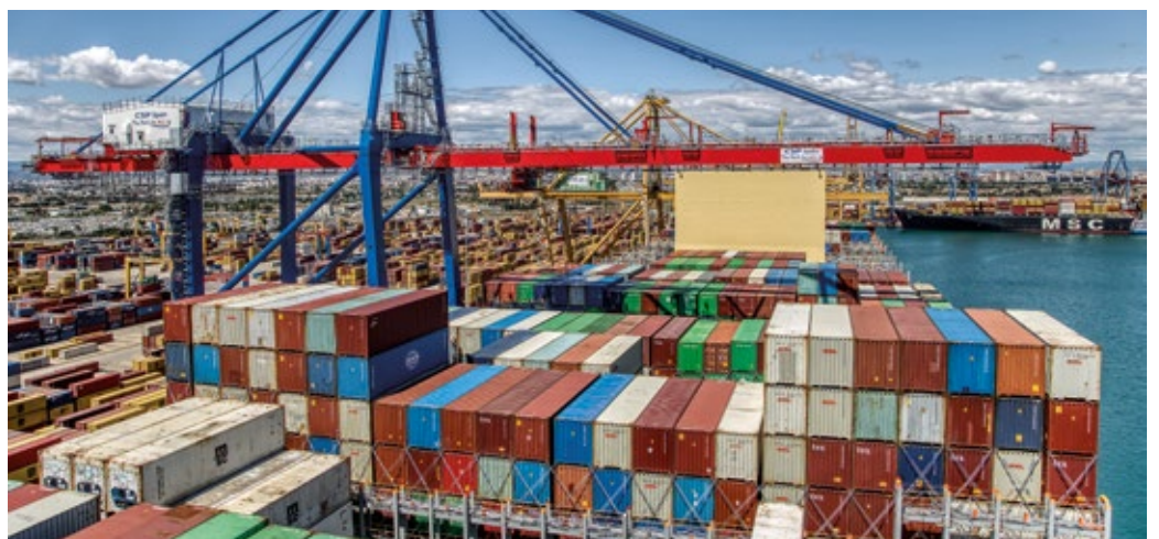
La electrificación de la maquinaria portuaria supone una transformación de los procesos operativos. / The electrification of port machinery is transforming operational processes.
