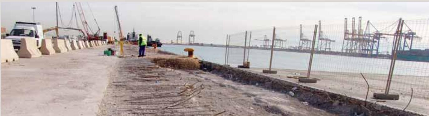
Preparación de la banda de rodadura para las grúas en el Muelle de Fangos en 2005.
