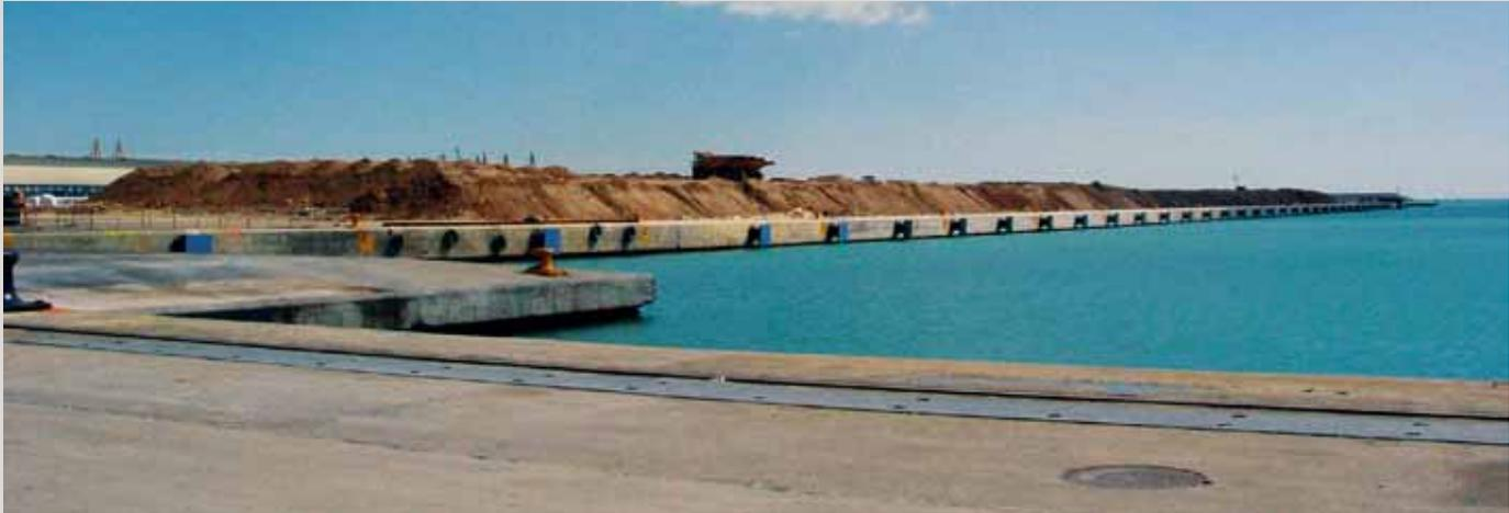
El Muelle de Fangos, que posteriormente acogería la concesión de TiL (Valencia Terminal Europa), en fase de consolidación de rellenos en 2004 tras la ejecución de la línea de atraque y asfaltado del muelle.
