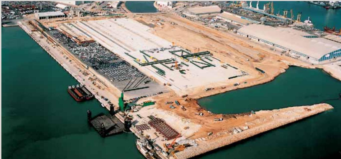
Aspecto de las obras en el Muelle de Fangos en diciembre de 2005. Se simultanearon las obras de relleno y consolidación con el montaje de las grúas y la adecuación de la línea de atraque. Y todo ello combinado con un espacio destinado a vehículos nuevos.
