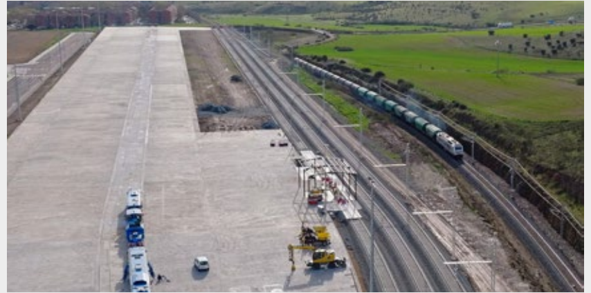
Los trabajos en la terminal intermodal de Zaldesa avanzan a buen ritmo.
